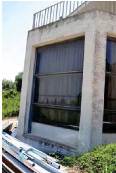
בסיס המרפסת – חצי המשושה בקצה ה"קפיטריה" – כיום אולם 116 פרטי מסגרות "חלונות הגליוטינה" המקוריים שהשתמרו באתרם, משמאל פרטי השביל ההיסטורי ; שימוש אבני שכבה טבעיות
