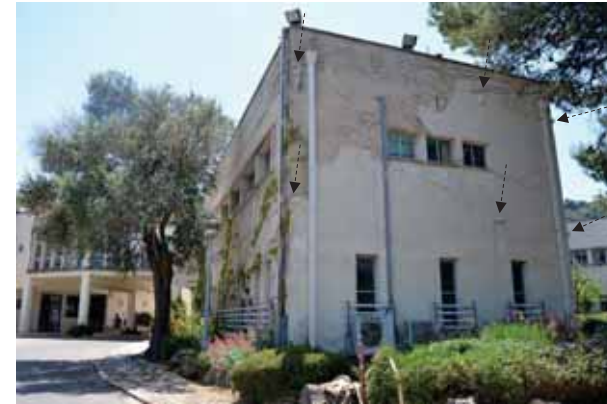
אגף B (חלק II) חזית צפונית שים לב למערכת המותחנים (מסומנים בחצים)
