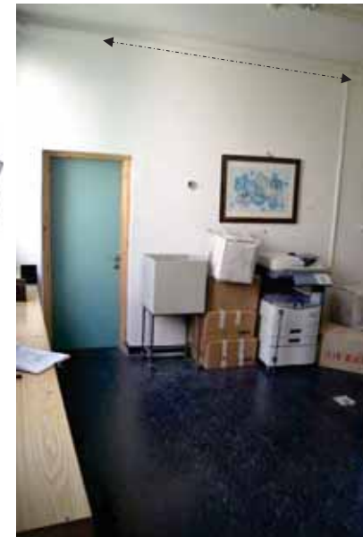
חדר פנימי בדופן אגף D ו-E ; תפר הבנייה מסומן בחץ שחור מקווקו
