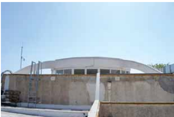
גג הפטרייה – מבט ממזרח. שים לב לקשתות החיזוק האופקי ועובי הקורה הטבעית
