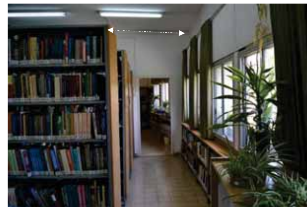
אגף E - קומה א' אגפי הספרייה המזרחיים משני צידי התפר בין אגפים E ו-D) ניתן להבחין בתפר לרוחבו של הפתח המעבר ובתקרת החדר
