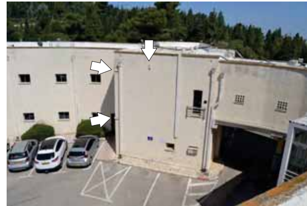
אגף B חזית דרומית, שים לב למותחנים לרוחב החזית (מסומנים בחץ), למטה הגדלה מקומית של עוגן אחד המותחנים
