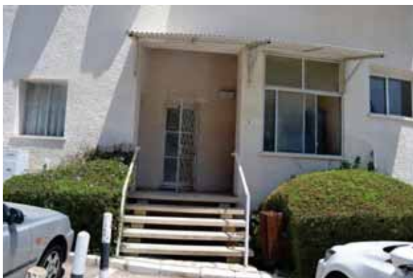
אגף D קומת קרקע – מדרגות כניסה למחסנים חדר 136
