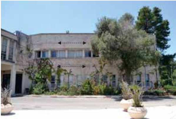
אגף B (חלק II) חזית מזרחית שים לב למערכת המותחנים (מסומנים בחצים)
